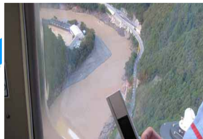
ヘリコプターを使った緊急的な被災状況調査
