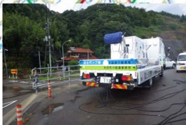
浸水対応のため排水ポンプ車の出動【高津川派川南田川水門】
