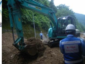
孤立集落解消に向けた土砂撤去【国道315号金山谷トンネル坑口付近】
