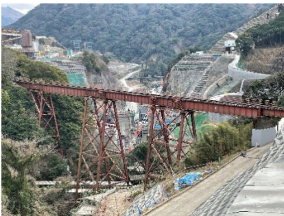
「立野ダム展望所」より一望できる立野ダム工事現場
