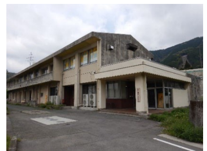
立野ダム建設事業について学習できる「あそ立野ダム広報室」
