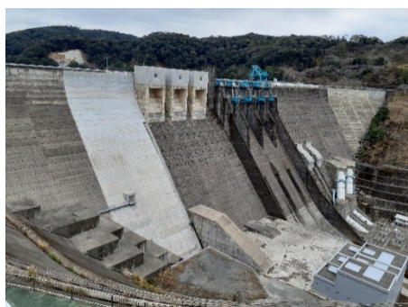
ダムの機能を維持しながら改造。 （さつま町内）
