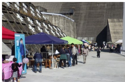
ツアーとは別に、放流を間近に見ることができるコンジット広場を一般開放し、令和 2 年度は約 800 名が来訪。同時に「ピクニックマーケット」を実施。
