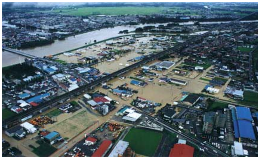
8月28日 / 阿武隈川上流(福島県郡山市金山橋周辺)
