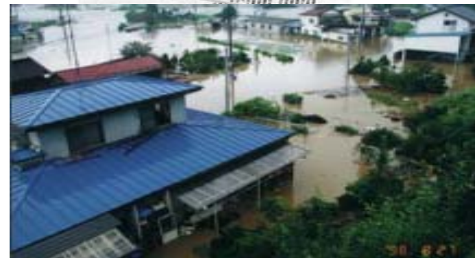
8月27日 / 阿武隈川(福島県須賀川市江持橋付近)
