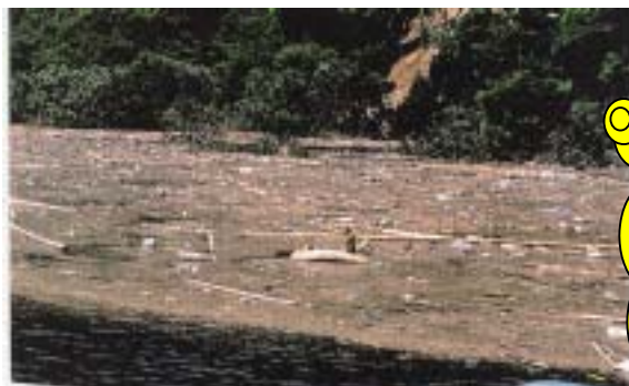
魚切ダムに貯まった流木
