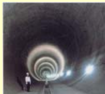
放水路 (約3.7km)
