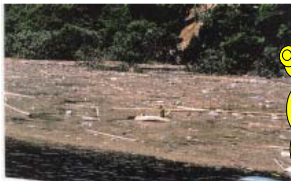
魚切ダムに貯まった流木
