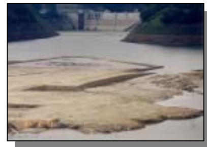
渇水の状況(日吉ダム(平成12年8月))
