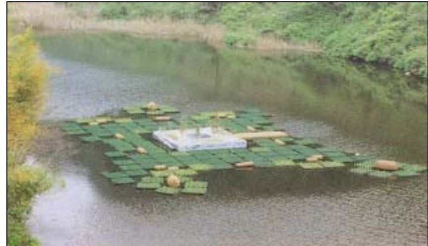
耶馬溪ダム(九州地整)の水質浄化人工浮島
