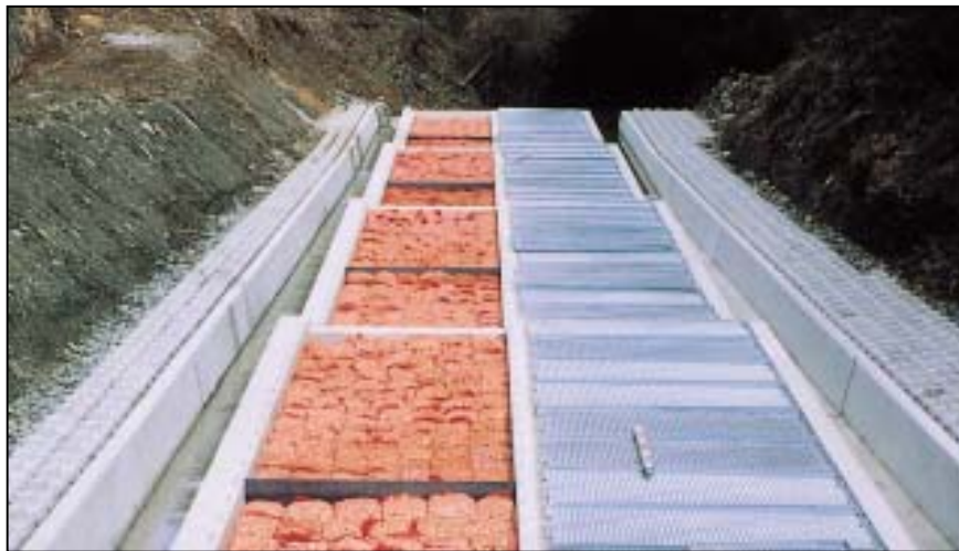
支川へのリン吸着材の敷設
