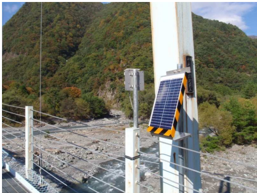
カメラ設置状況
