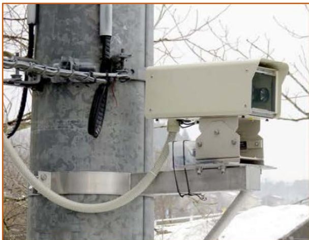
※既設マストへの設置例(新潟県)
