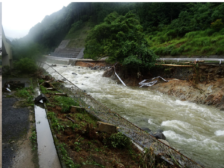
「九州北部豪雨災害状況」(株)東京建設コンサルタント撮影
