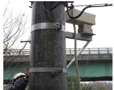
既設マストへの設置例
