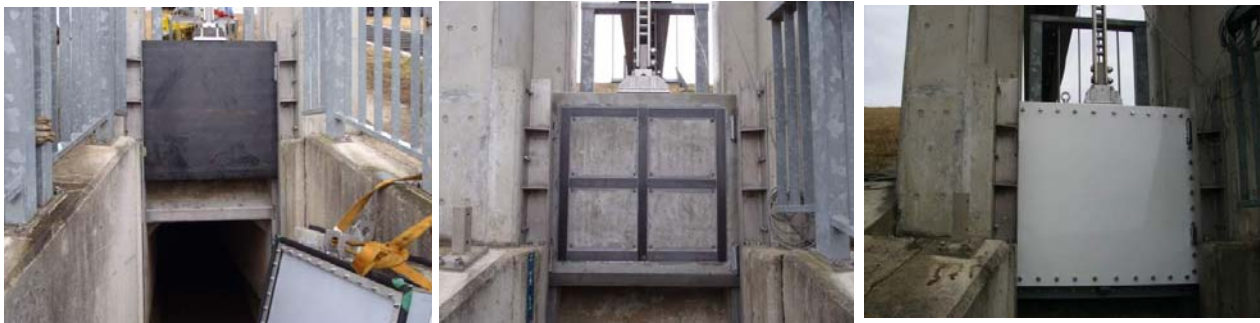
写真-3 ラック棒取り付け状況(左より、PP-GF、コンクリートパネル+CFRP、CFRPVC+PVC 桁)
