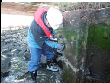
図15 超音波厚さ計による残存板厚の計測
