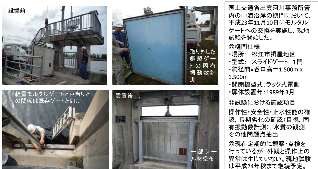
図-10 塩水環境での現地試験状況：
