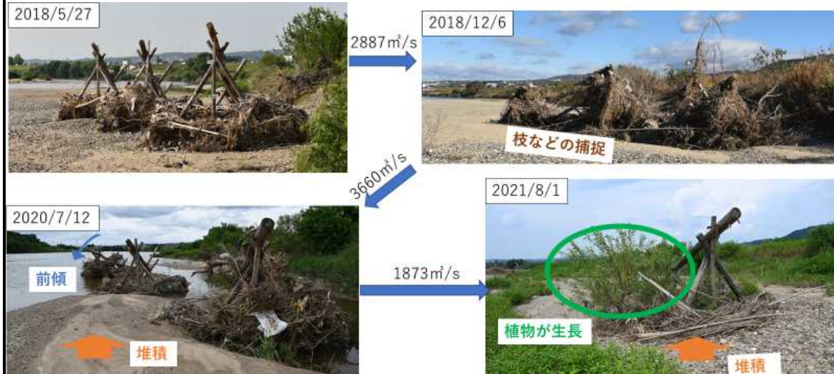
図 1-1-2 設置後の聖牛の変形
