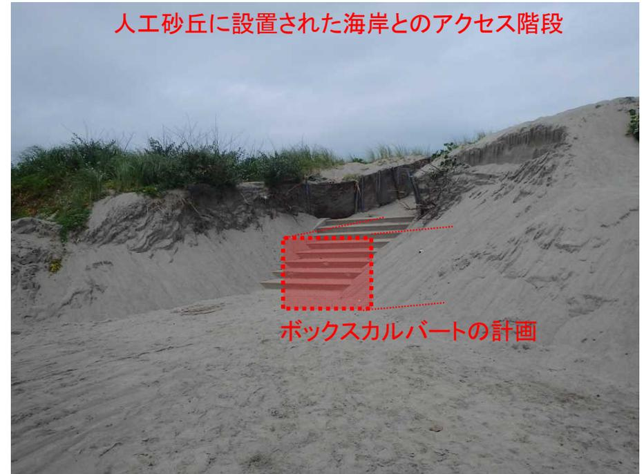
・コミュニティ協議会では、新潟市と協力して飛砂防止対策を継続的に実施していますが、飛砂防止施設設置により、海岸への利便性(アクセス)が損なわれます。このため利便性を確保するため人道ボックスカルバートの設置を飛砂防止施設とあわせて行います。
