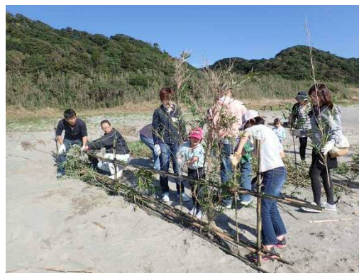
堆砂垣の設置（砂浜保全）
