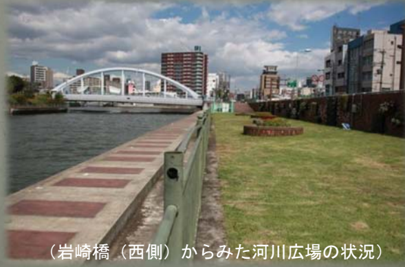
（岩松橋（大正駅前）からみた河川広場の状況）
