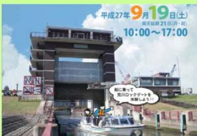
荒川ロックゲート
