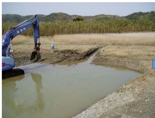
底面緩傾斜工事の状況
