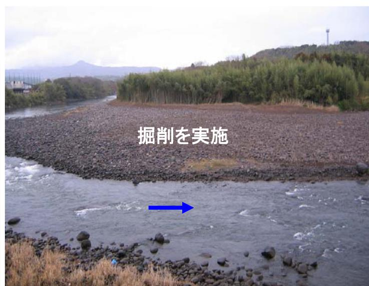
玉石を残して堆積土砂を掘削
