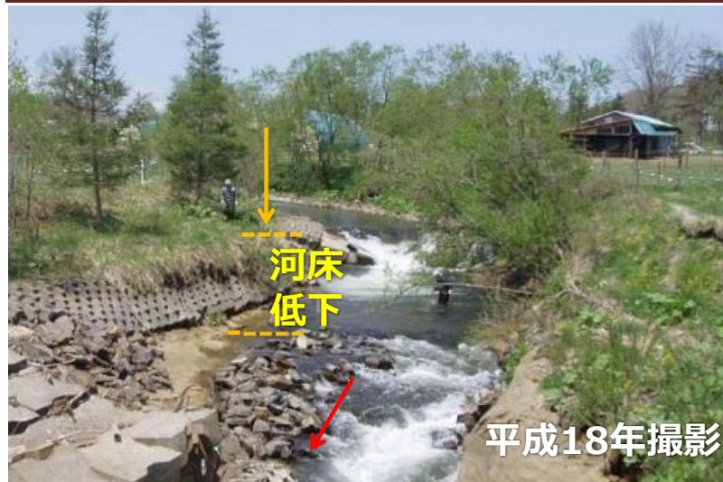
河床低下区間最上流端の対策前後の状況
