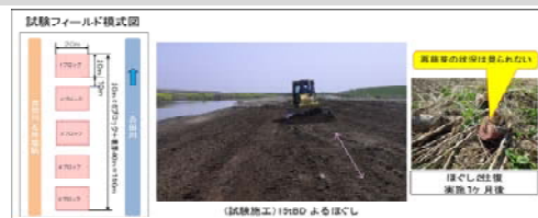
図4.ブルドーザによるほぐし試験状況
