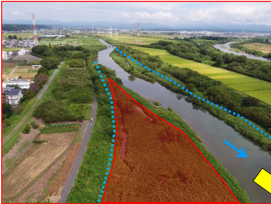
二瀬西橋付近から上流を望む(R2.3撮影)
