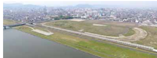
整備前の写真→
