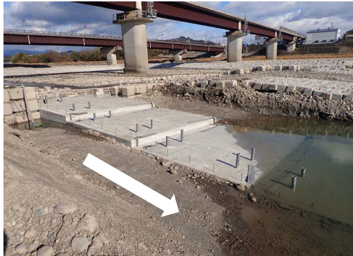
水路底盤コンクリートの構築
