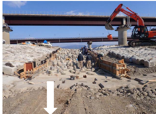
水路側壁の構築及び深掘れ対策
