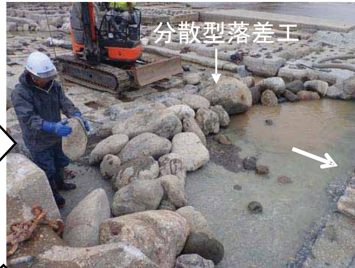
分散型落差工の設置
