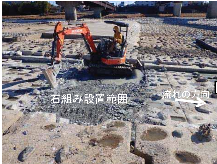
既設水路のコンクリートのはつり
