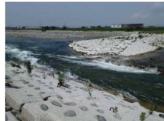
東水路下流端
