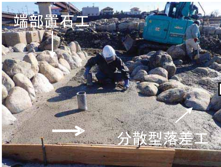
コンクリートと差筋による石組みの固定
