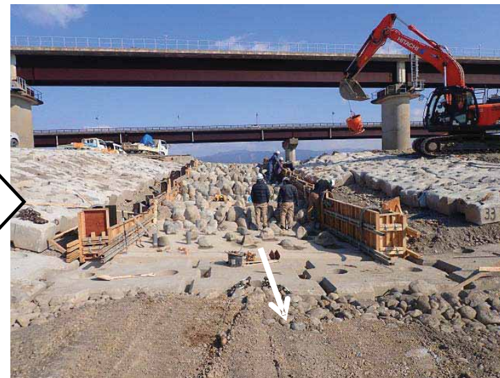
ブロック据付と側壁の構築
