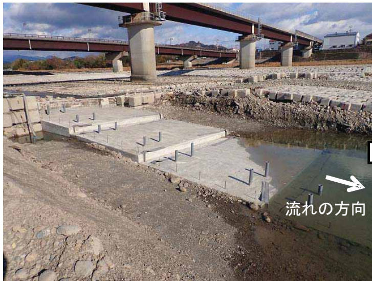
水路底盤コンクリートの構築
