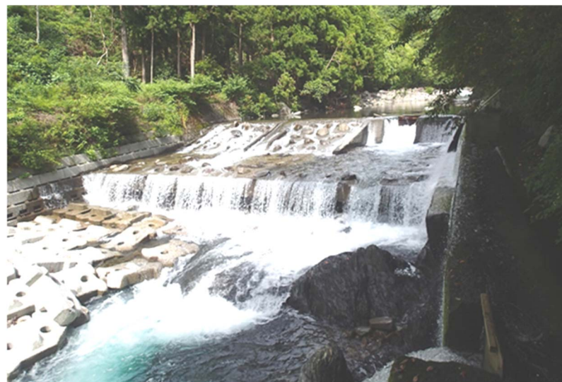
魚道未整備(冬の瀬頭首工)
