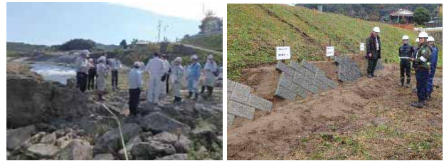
整備箇所の確認
