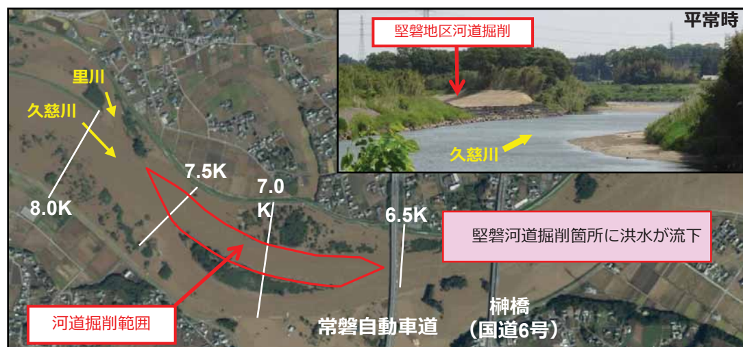
図27 令和元年10月洪水時の堅磐河道掘削箇所の状況
