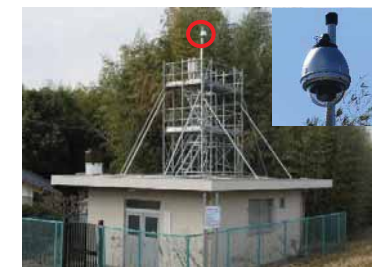
図10 定点カメラの設置状況
