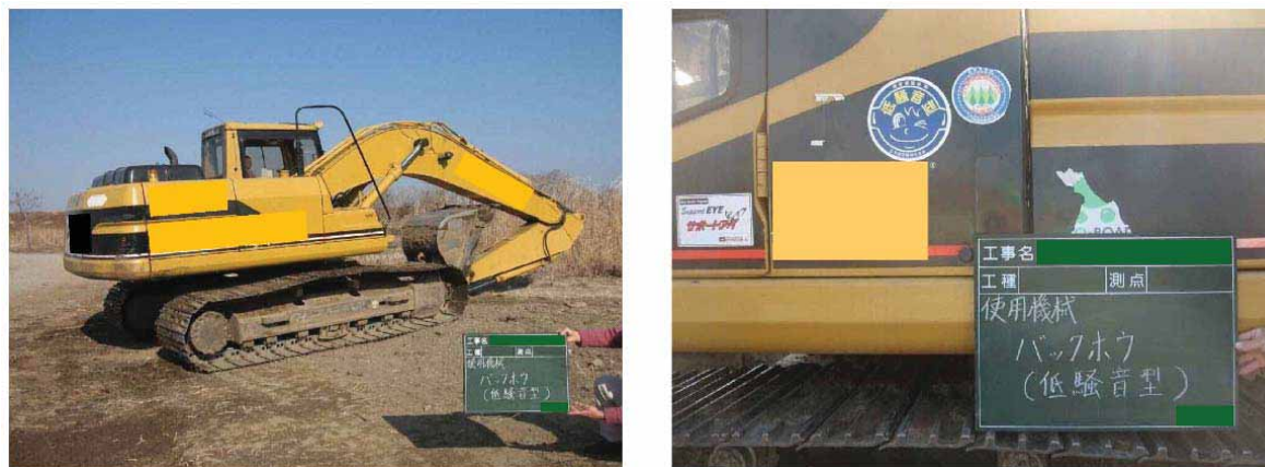
図9 低騒音型建設機械の使用
