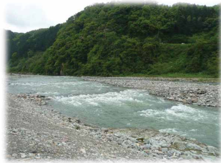
水制工設置後の状況(H22年)
