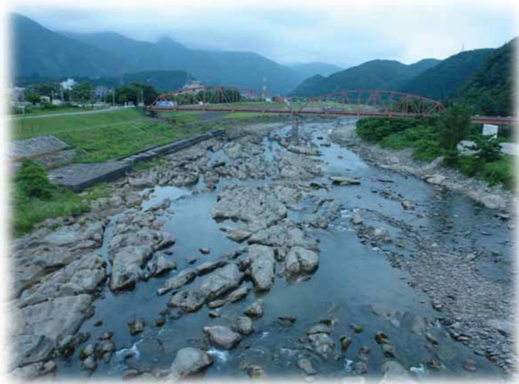
施工前における岩盤露頭状況(H18年)
