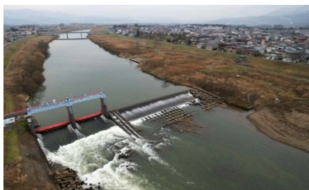
上越工業用水道取水堰(H22撮影)
