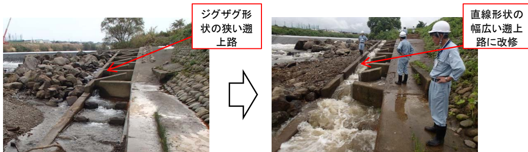
改修前の状況(H26撮影)
