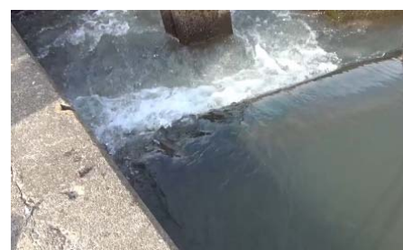
左岸魚道の様子(H30撮影)
