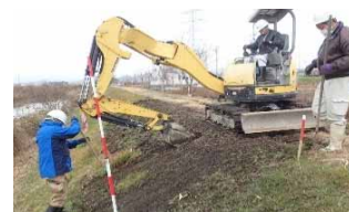
植栽基盤整備
