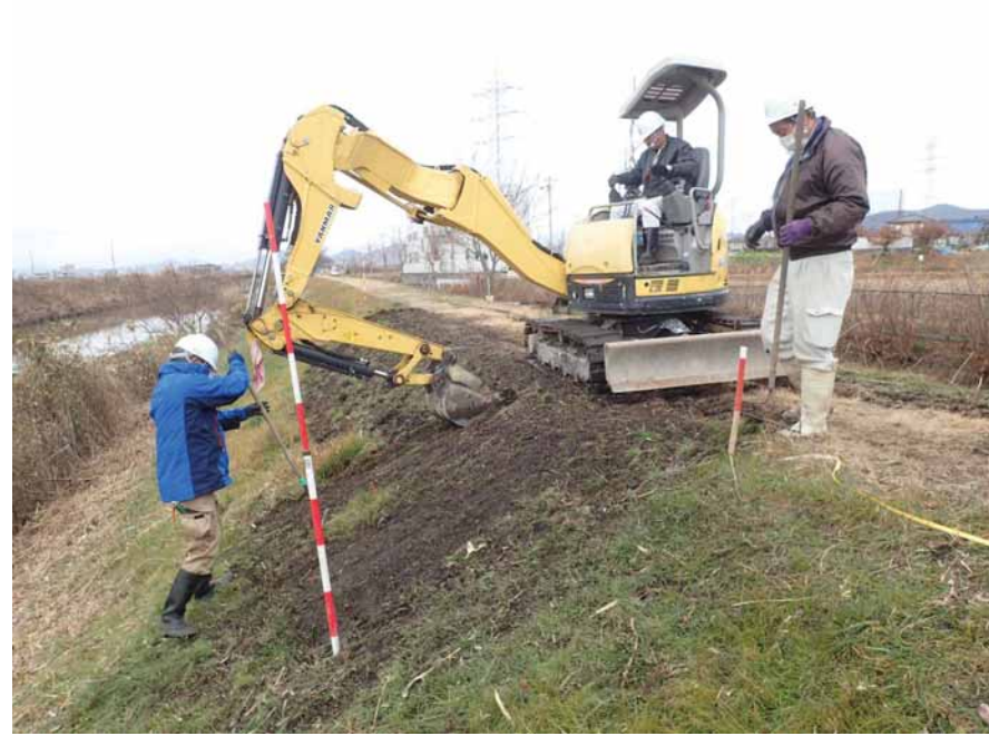
植栽基盤造成とクズ・ササ等根系除去
