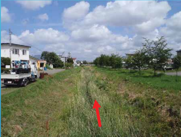
南10線橋下流(上流部)
