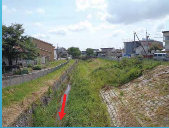
善隣橋より上流(中流部)
