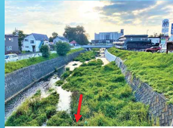
蹄橋より上流(下流部)
