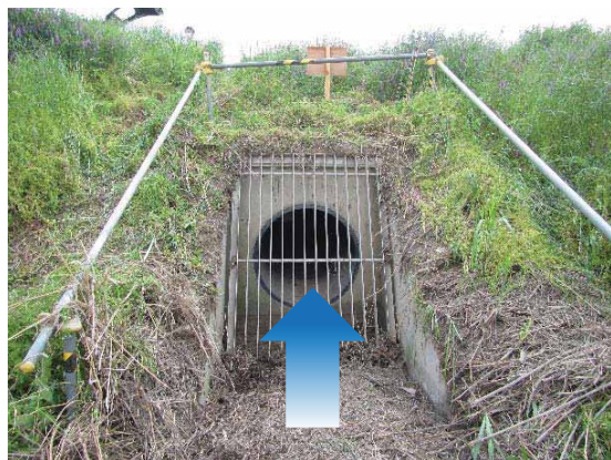
呑口(φ1000) 2009施工
