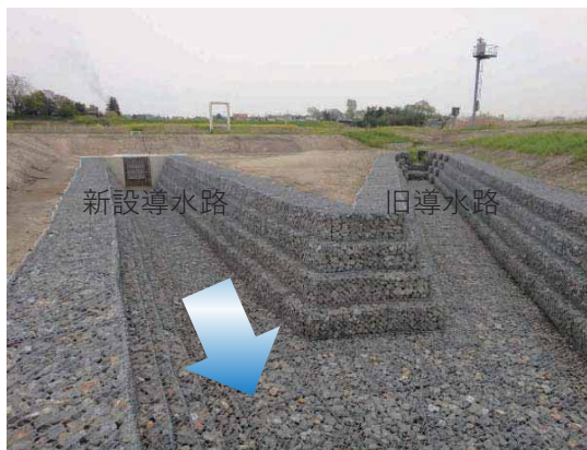
導水路(かごマット) 2009施工
