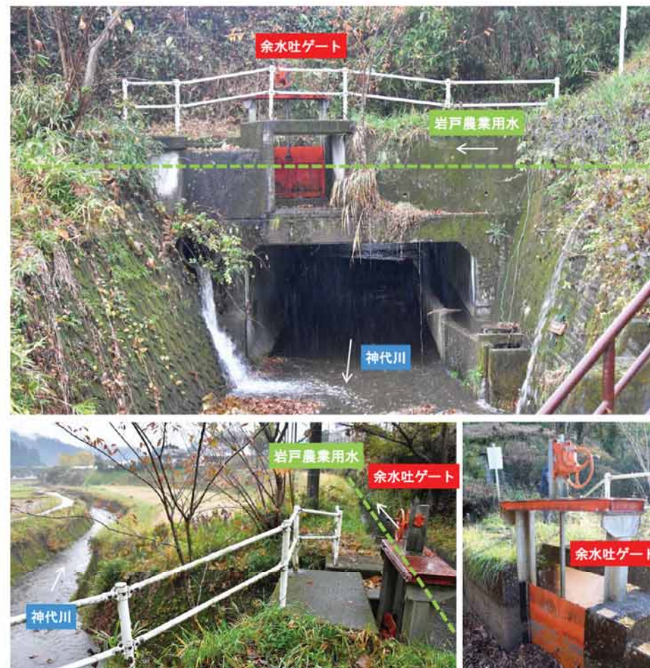
宮尾野農場付近の余水吐ゲートの状況（岩戸農業用水）
