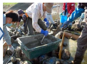
手練りしたコンクリートで石を付ける
