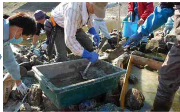
手練りしたコンクリートで石を付ける
