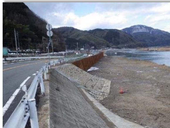
護岸工事の状況 (平成29年2月)
