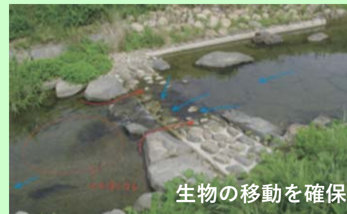
帯工表面仕上げの工夫
