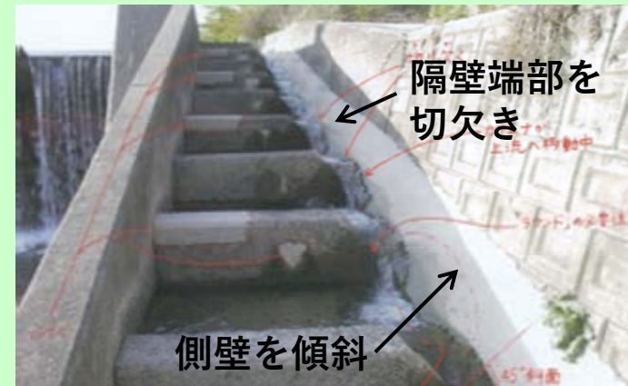
小わざ魚道（側壁・隔壁の加工）
