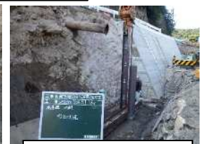
過年度 H鋼施工状況
