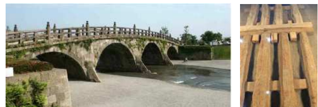
写真 移設・保存された西田橋、アーチ基礎部
