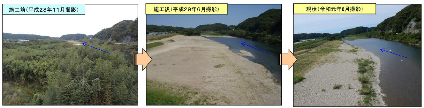
西益田大橋下流
