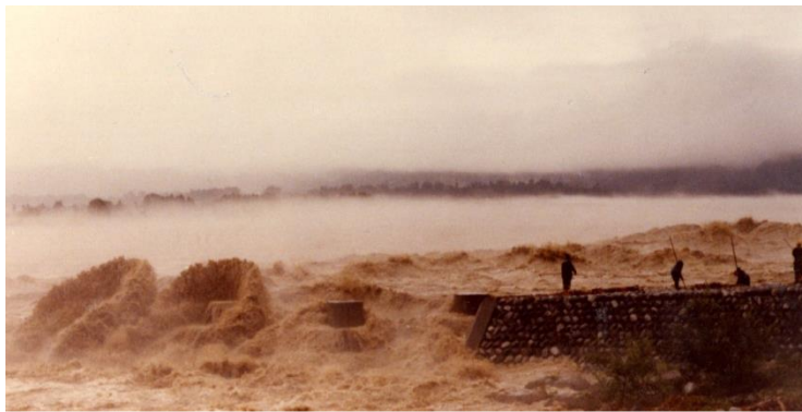
激流をうける水制 (S44.8洪水)
