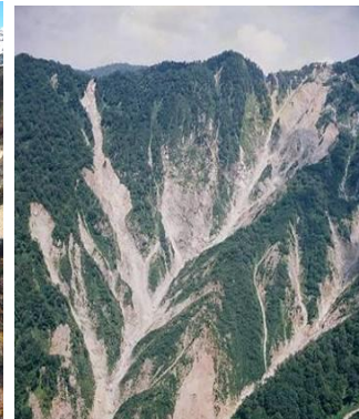
不帰谷崩壊地
