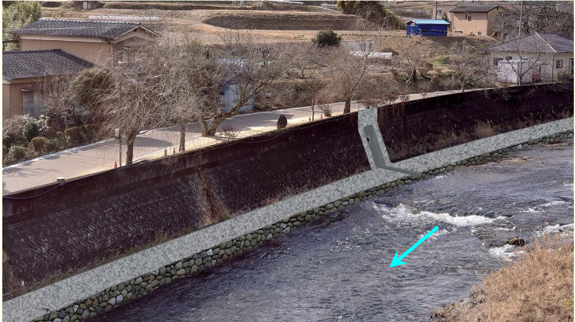
コンクリート洗い出し仕上げ
