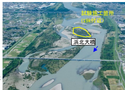
H27航空写真 天竜川19k付近 樹木繁茂状況
