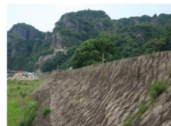
周辺景観と馴染んだ石積み護岸【青地区】
