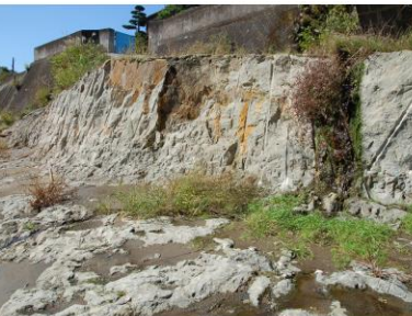
静的破砕剤(膨張剤)で岩を割ってブレードで粗く仕上げた岩河岸 (山国川 平田地区左岸)
