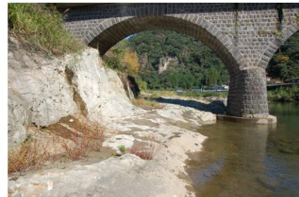
静的破砕剤(膨張剤)で岩を割ってブレードで粗く仕上げた岩河岸 (山国川 平田地区左岸)
