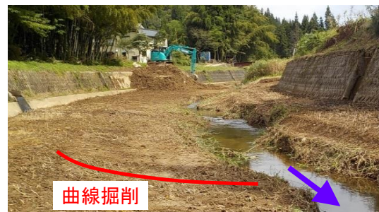
写真：曲線断面掘削完了
