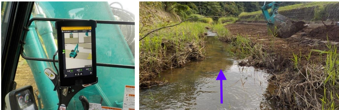
写真：ICT施工による曲線断面掘削の状況
