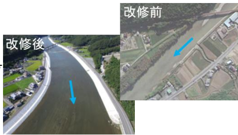
川幅が約2倍となった箇所(上郡町:千種川)
