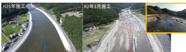
R2施工箇所の着工前後比較(上郡町:千種川)
