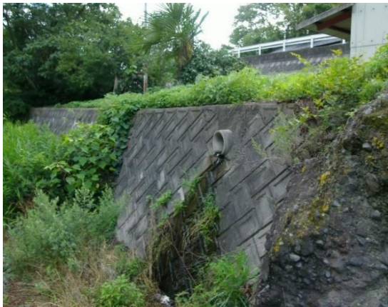
整備前のブロック積護岸
